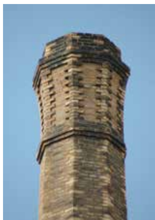
22 Corona en fulla de tabac amb enfonsats revestits en cremallera, amb filades simples en imposta i cornisa. Fumeral de l'Alqueria Dolores.
