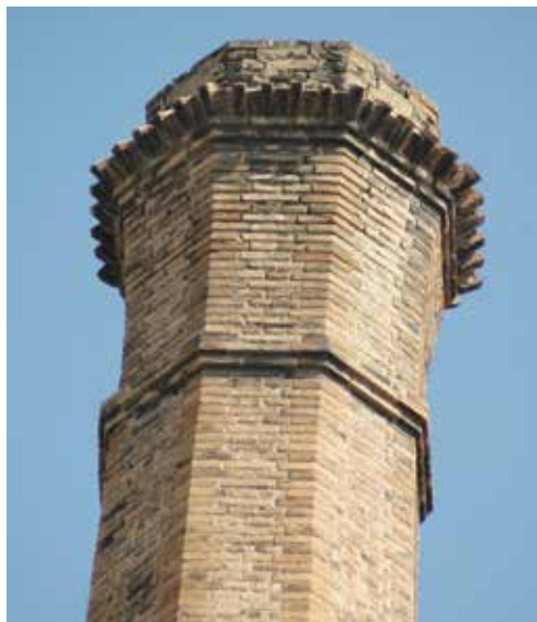
18 Corona en fulla de tabac sense enfonsats i amb peces de cantoneres formant la cornisa. Fumeral del rajolar de Cayetano Cánoves.
