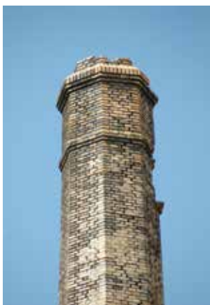
23 Corona recta sense enfonsats, amb filades simples en imposta i cornisa, que remata amb peça de cantonera a plec de llibre formant el bordó. Fumeral de Cerámica Aldayense.
