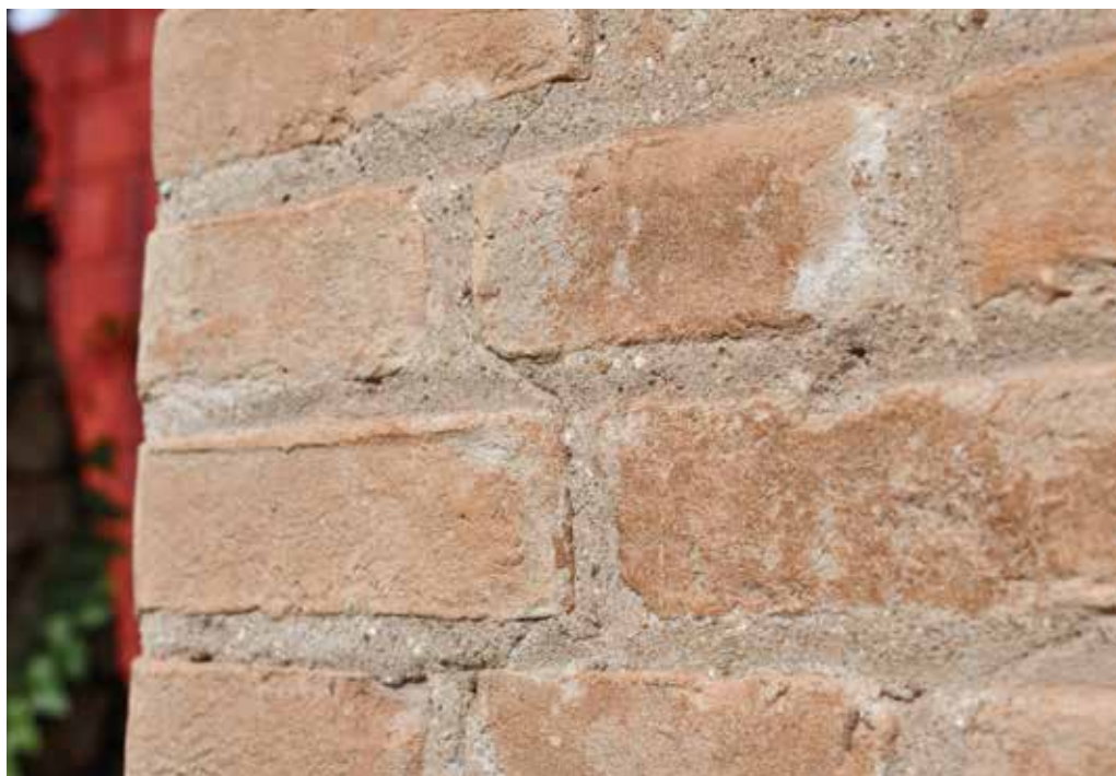
7 Morter amb àrid de bastant grandària en el fumeral del rajolar de Cayetano Cànoves.
