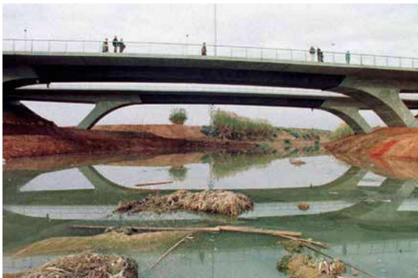
< Obres d'un pont de l'AVE al terme de Picanya. Any 2010.
