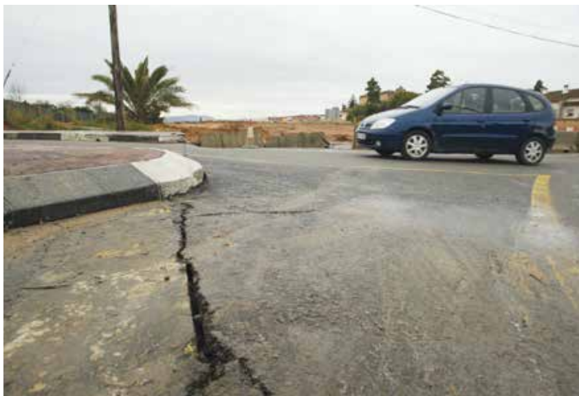
< Corriment d'asfalt que va provocar l'obra de construcció del túnel de l'AVE al terme d'Alaquàs, junt a la redona del Poliesportiu Municipal El Terç, en maig de 2011.
