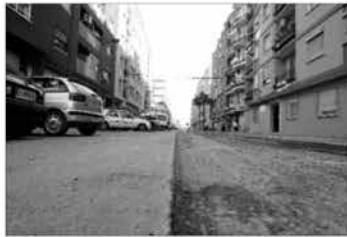
PAVIMENTACIÓN. Las obras de la parte de Xirivella comenzaron ayer.
